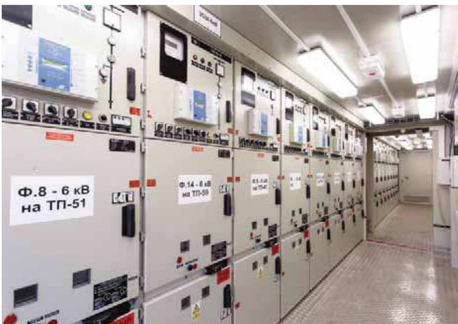
• Закрытые распределительные устройства (ЗРУ) устанавливаются в специальном здании, которое защищает их от атмосферных воздействий. Они используются на напряжениях до 10 кВ. В отдельных случаях, когда электроустановка размещается в условиях с агрессивной окружающей средой (повышенная влажность или запыленность рабочей зоны, морской воздух), допускается применение ЗРУ на напряжение вплоть до 220 кВ.
